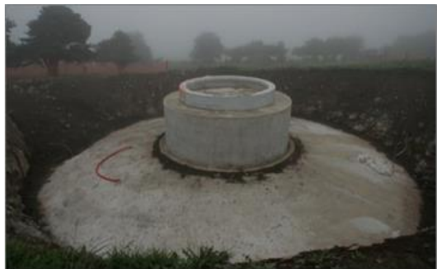
Figura 8. Fundação de concreto de um aerogerador (16 metros de diâmetro). Fonte: Voltalia/2023.
